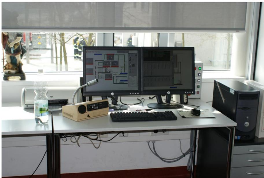
Von einem **Leitstand im Nebengebäude** aus, kann der gesamte Einsatz überwacht werden. Sollten Probleme bei einem Trupp auftreten, so sind einerseits **Nottaster im Brandhaus** installiert, bzw. kann auch vom Leitstand aus **das Feuer jederzeit gestoppt werden** und die Belüftung des Raumes aktiviert werden. So wird den zu übenden Trupps die größtmögliche Sicherheit geboten.
